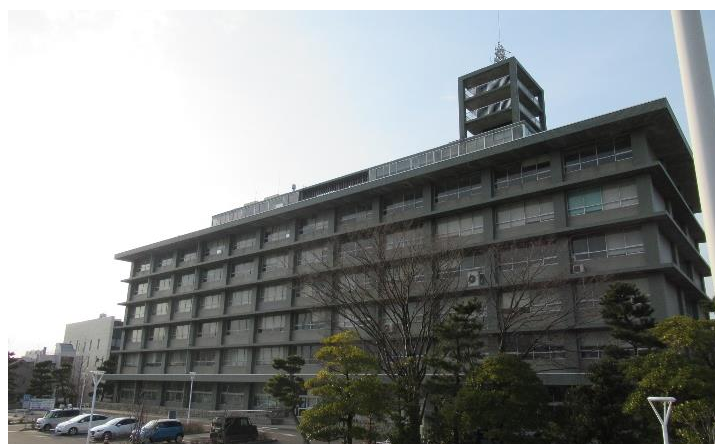
(老朽化した市役所旧分館)
