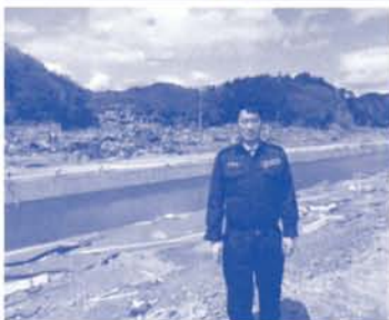
防波堤があったにもかかわらず、海岸沿いの集落は見る影もなく、巨大津波の威力のすさまじさに言葉もありませんでした。
